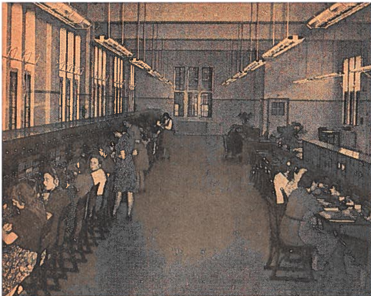
De TL verlichting in de telefoonzaal te Rotterdam.
